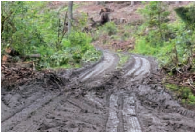
Instandsetzungsbedürftiger Weg nach intensiver forstlicher Nutzung.
