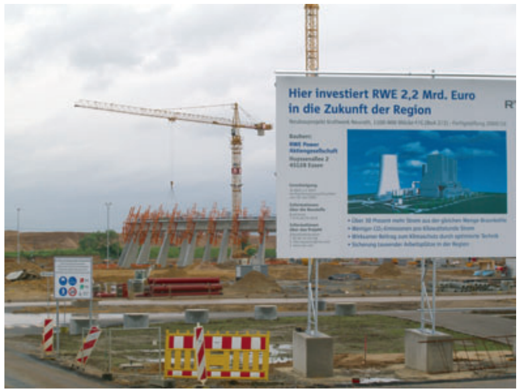
Großprojekte wie der Bau der beiden Braunkohlekraftwerke in Grevenbroich müssen nach Meinung der SPD gut vorbereitet sein - Alleingänge aus Prestige Gründen seien nicht angebracht.
