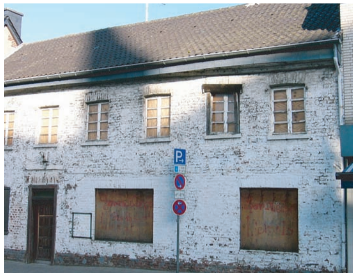
Nach dem Abriss der ehemaligen Gaststätte „Zur Post“ entstehen dort 17 altengerechte Wohnungen.
